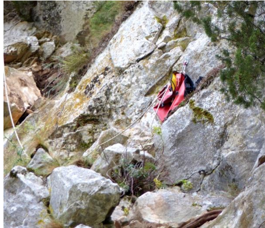
zoom sur la zone de purge avant et après
