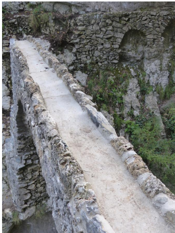
dévégétalisation canal aqueduc
